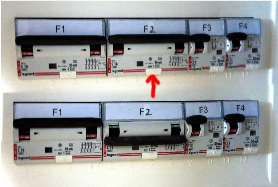
Attention : le disjoncteur F1 est très sensible, il n'y a pas besoin d'une surcharge, un simple petit défaut d'un appareil peut le déclencher.
